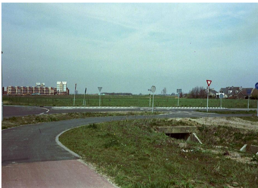
[11] Entree landgoed Haverleij s’-Hertogenbosch (toekomstig bosgebied). Links het zojuist opgeleverde kasteel Zwaenenstede van architect Arnaldo Natalini, rechts daarvan ligt een ‘uitbreidingsplak’ van Engelen (2002).
